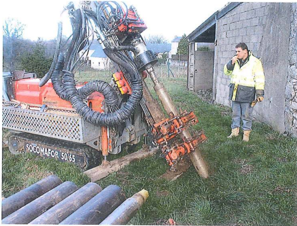
BASSENEUILLE 1 : Mise en place de l'ODEX
