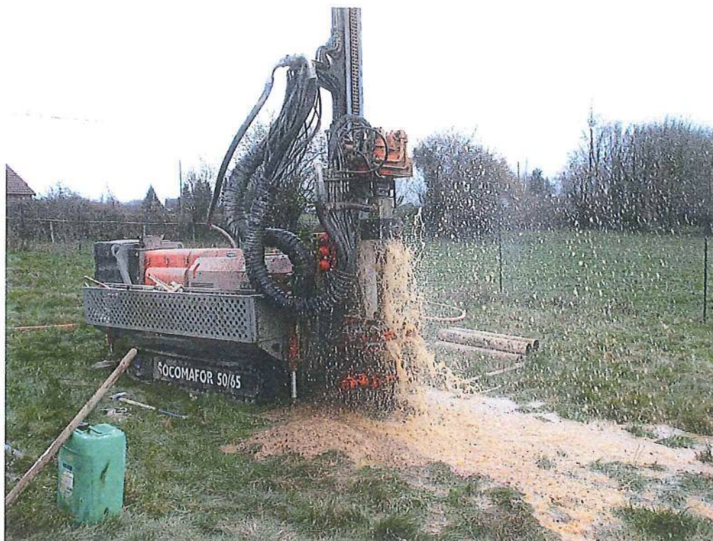
BASSENEUILLE 2 : Arrivée d'eau à 10,3m
