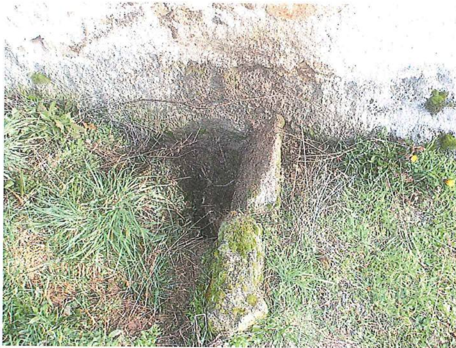
BASSENEUILLE 1 : Sortie d'air au niveau du mur
